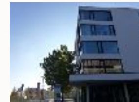
Pflanzung zu nah am Gebäude
